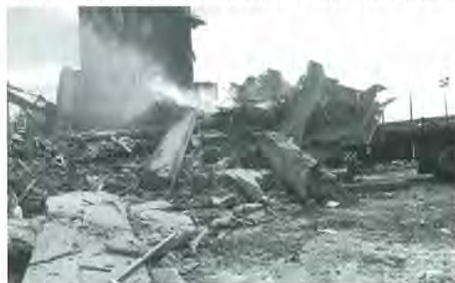
写真1 崩壊したCTVビル Photo 1 Collapsed CTV Building
