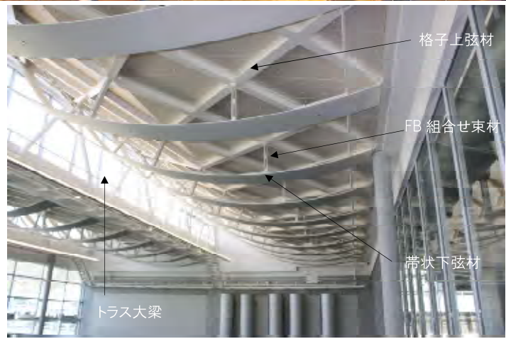
格子と帯状部材からなる屋根架構
