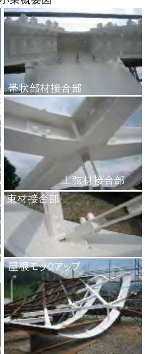
ハイサイドライト高低差を利用したトラス大梁:ワーレントラス 鉄骨造トラス小梁 上弦材:水平ブレースを兼用するH形鋼格子梁 下弦材:帯状のFB組合せ 上弦材(格子梁) H-150x150 束材 2FB-9x100 下弦材2FB-t9 600 トラス小梁概要図
