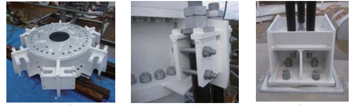
A: 上段ケーブル取付部 B: 下段ケーブル取付部 C: ケーブル取付部
