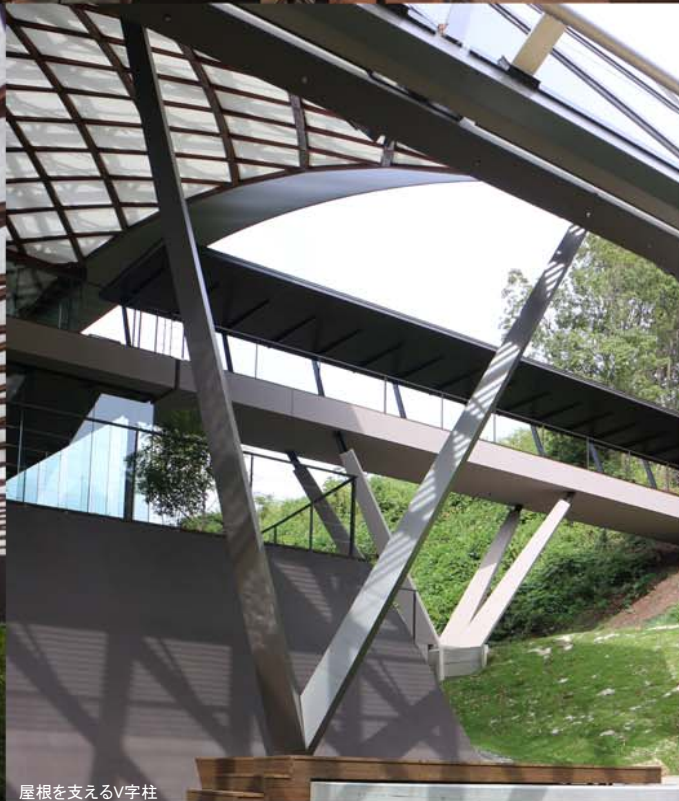
屋根を支えるV字柱
