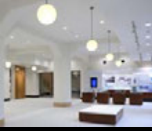
RC丸柱+ハンチ梁(再生後)
