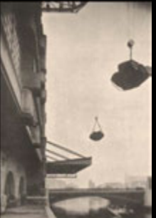
江戸橋を望む(既存建物創建時)
