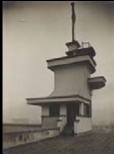
船橋状塔屋(既存建物創建時)
