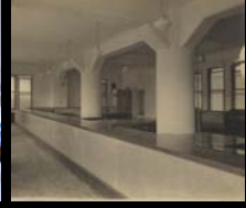
RC丸柱+ハンチ梁(既存建物創建時)
