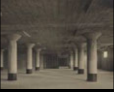
フラットスラブ(既存建物創建時)
