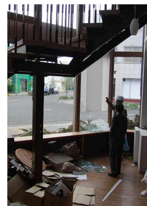
調査状況 (建物所有者への説明)
